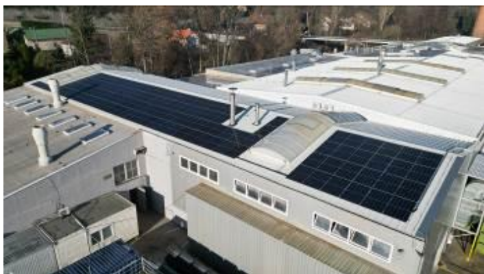
Fotovoltaická elektrárna v Dražicích
